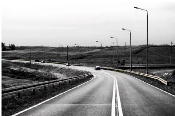
fot. MARZENA SAMBORSKA, tytuł zdjęcia „W drogę”. Zdjęcie przesłane w ramach konkursu fotograficznego „ZPORRe zmiany w regionach”. Budowa obwodnicy miasta Wąbrzeźno, województwo kujawsko-pomorskie
