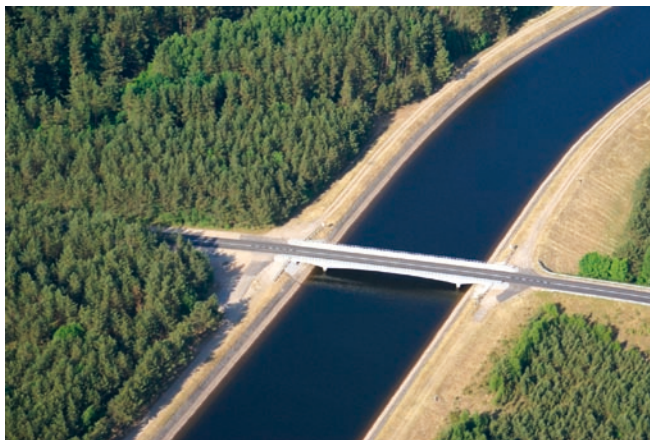
fol. ANDRZEJ KISIEL, tytuł zdjęcia „Z góry widać lepiej”. Zdjęcie przesłane w ramach konkursu fotograficznego „ZPORRe zmiany w regionach”. Przebudowa mostu w Żydowie wraz z dojazdami w ciągu drogi wojewódzkiej nr 205, województwo zachodniopomorskie
